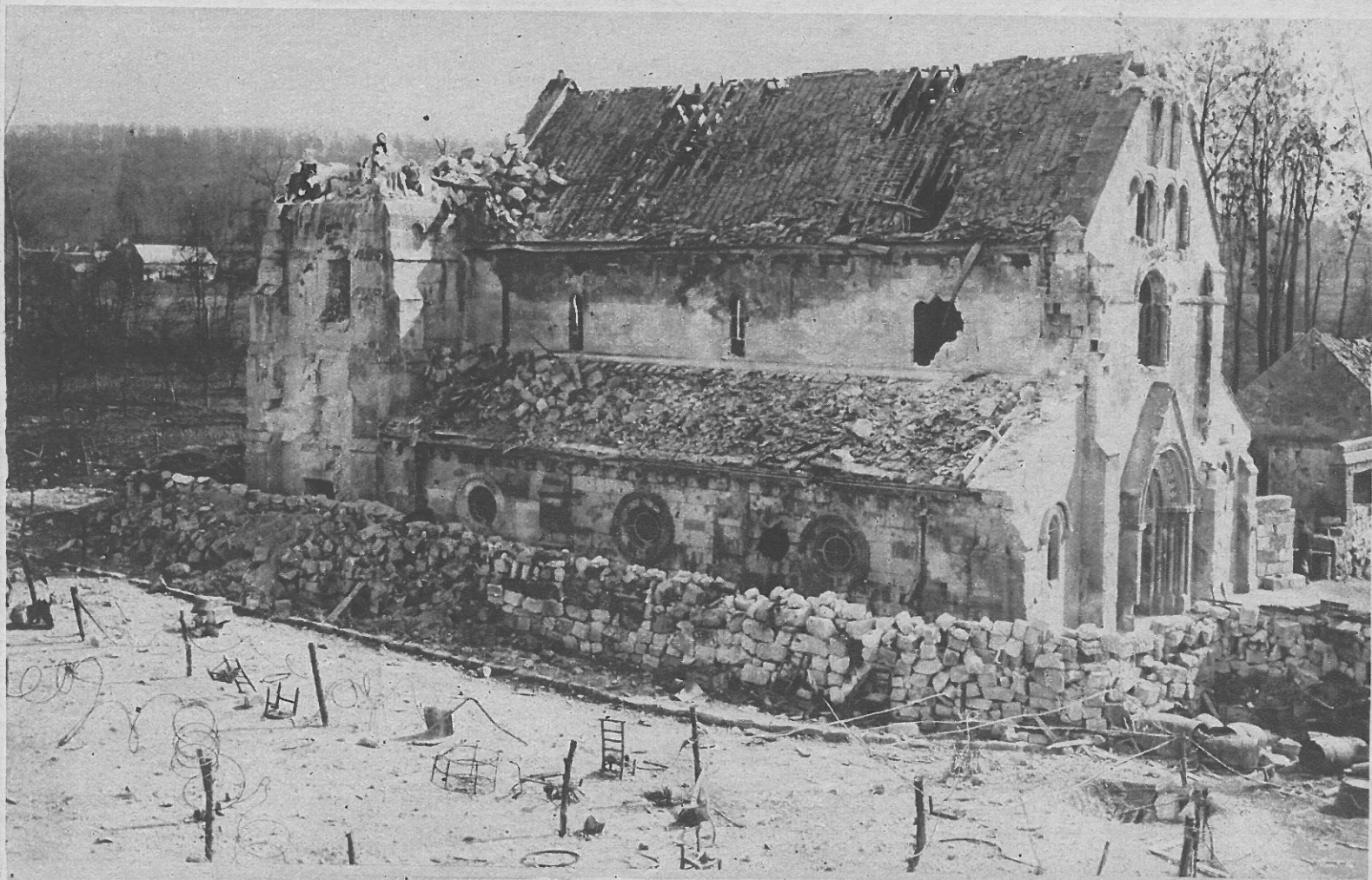
— Poteau indicateur dans une tranchée à Tracy-le-Val et l'église de cette localité. —
