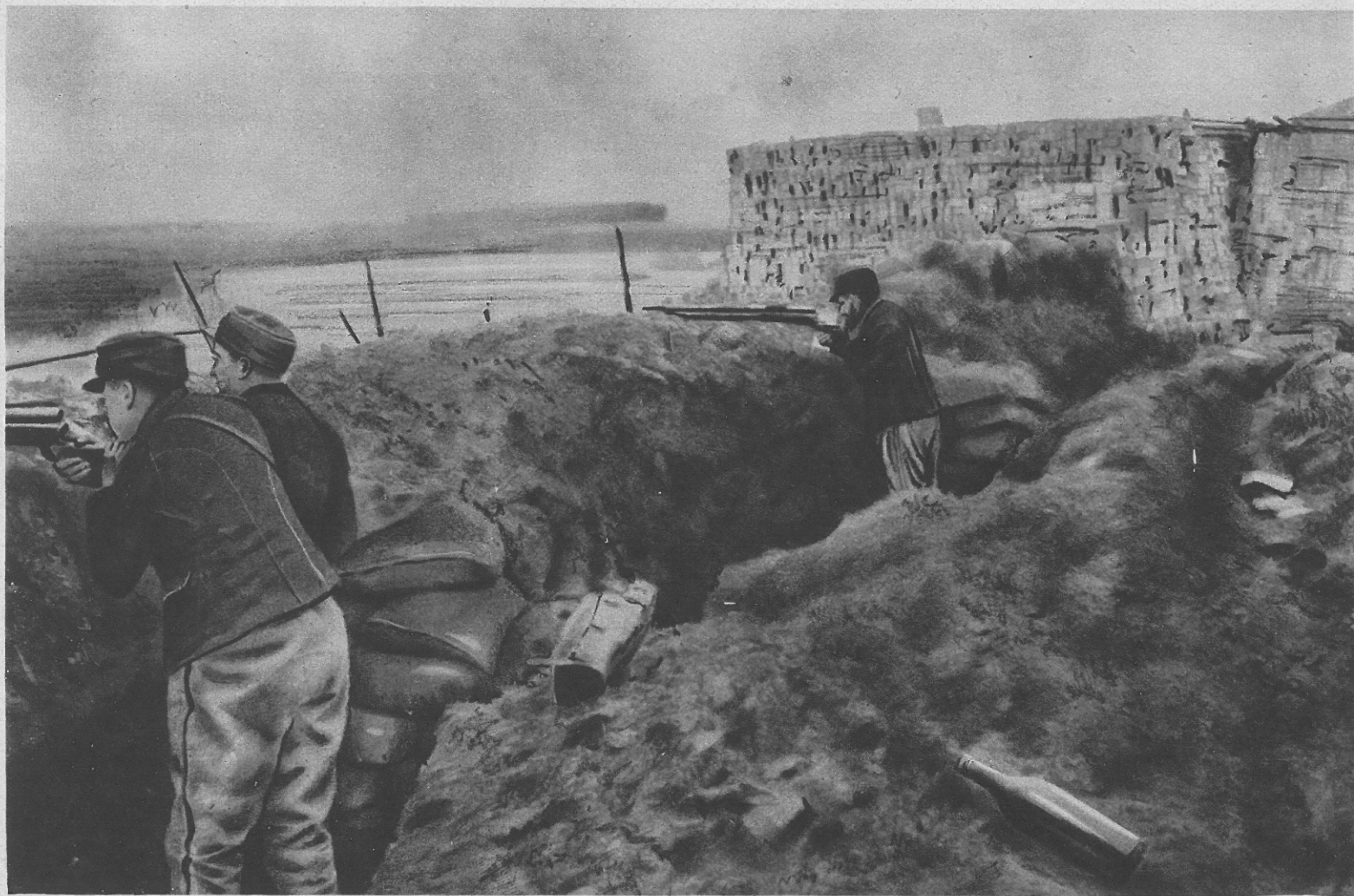
UNE TRANCHÉE DANS LAQUELLE LES BELGES SE SONT HÉROÏQUEMENT MAINTENUS
