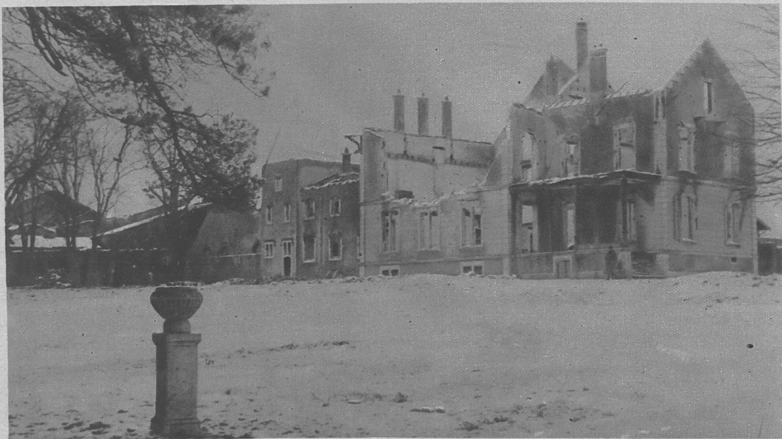
LA MAISON D'HABITATION COMPLÈTEMENT EN RUINES, VUE DU JARDIN
