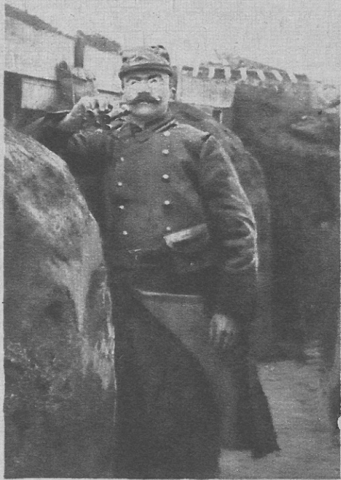
ENTRÉE D'UNE TRANCHÉE LUXUEUSE
