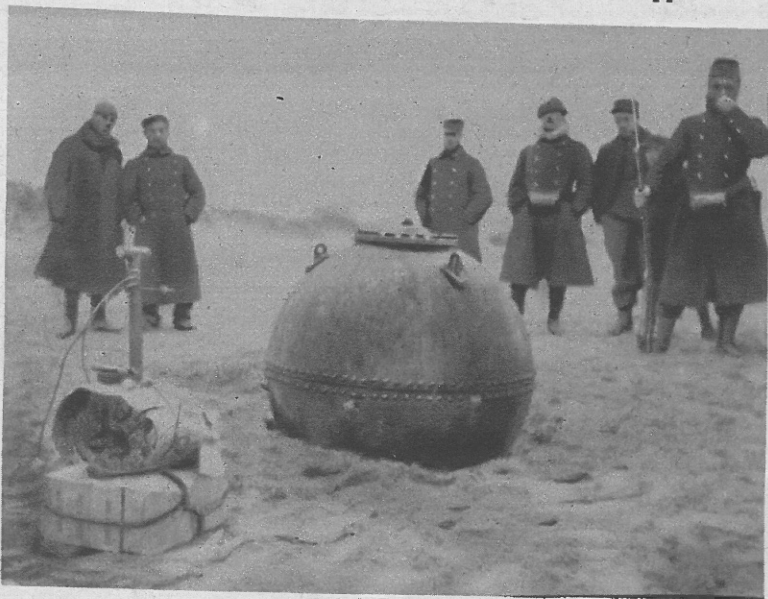
MINE SOUS-MARINE ÉCHOUÉE EN BELGIQUE Cette mine est venue s'échouer sur la côte belge entre Saint-Idesbald et la Panne. Elle contenait 30 kilos de coton-poudre.
