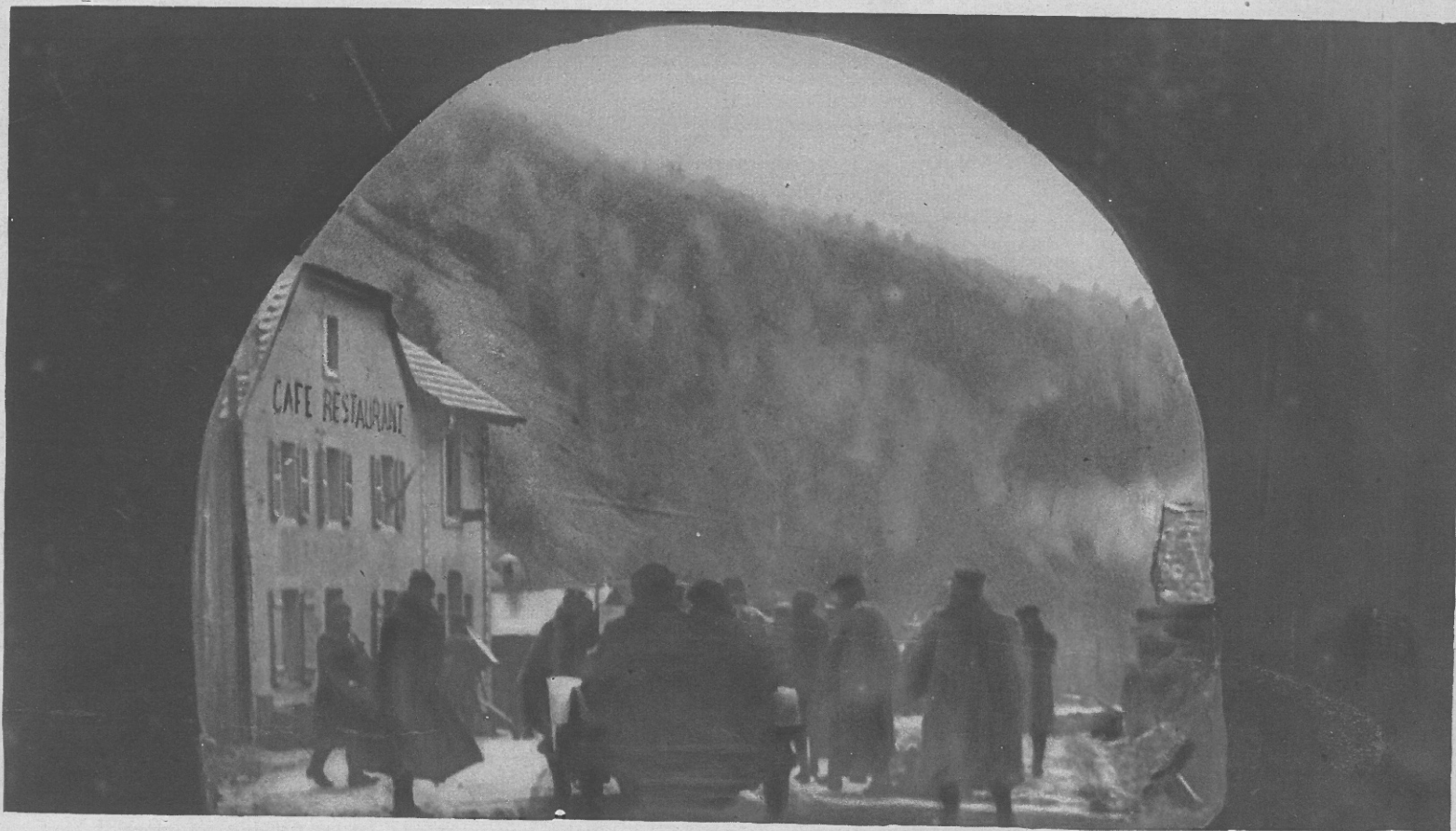
LA SORTIE DU TUNNEL DU COL DE BUSSANG QUI DÉBOUCHE EN TERRE D'ALSACE
