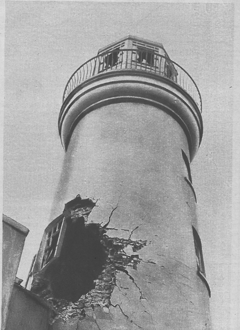
LE PHARE DE SCARBOROUGH PERÇÉ D'UN TROU ÉNORME
