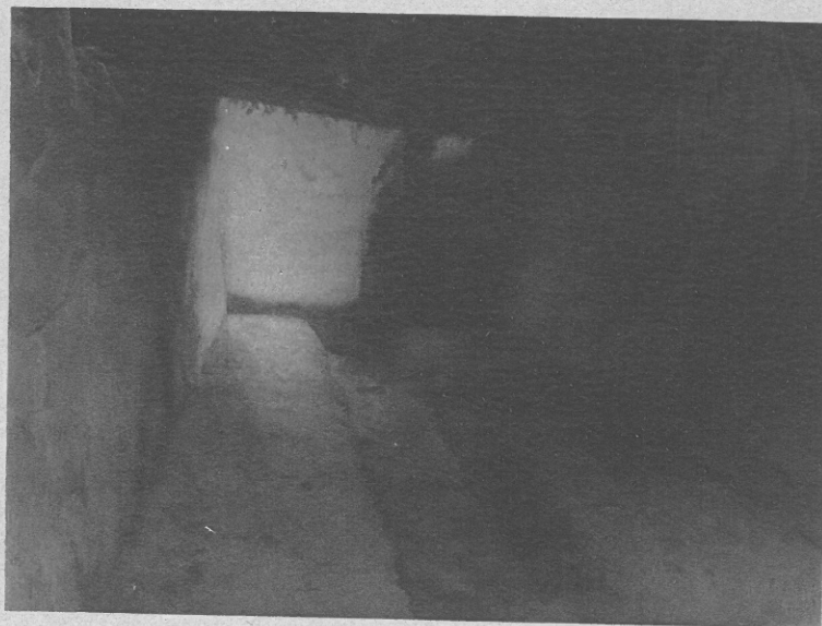
VUE INTÉRIEURE D'UNE TRANCHÉE COUVERTE
