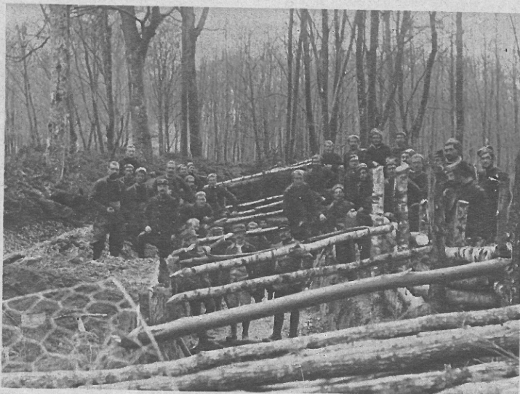
UNE TRANCHÉE COUVERTE EN VOIE D'EXÉCUTION
