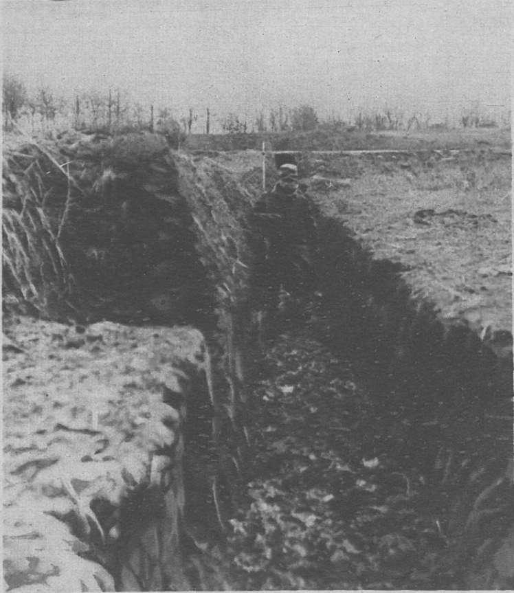
UN "BOYAU" D'ACCÈS AUX TRANCHÉES
