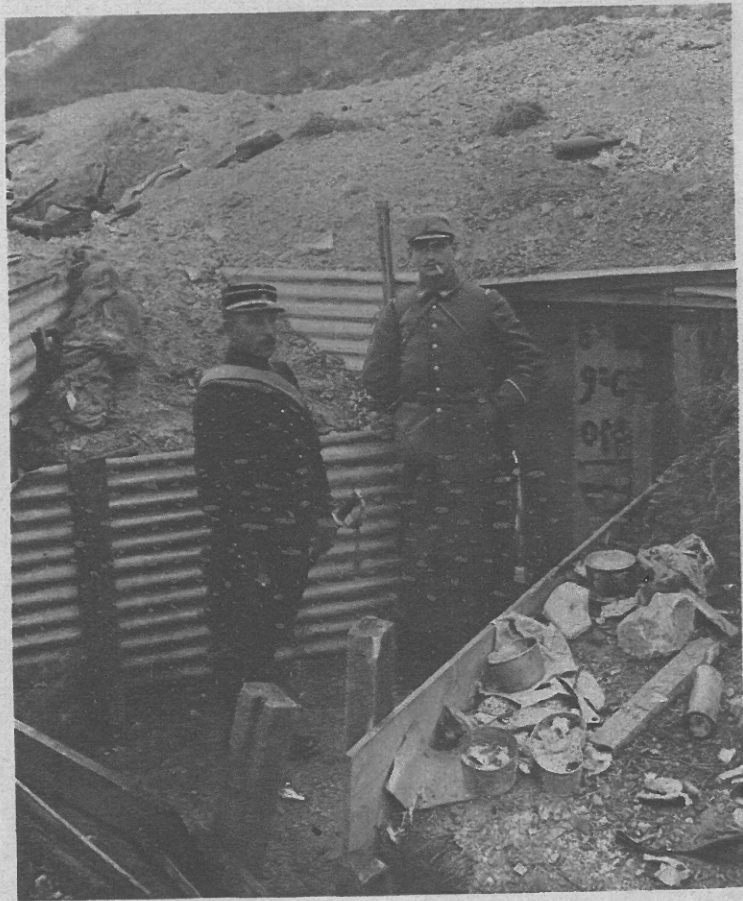
L'ENTRÉE D'UNE TRANCHÉE DE SECONDE LIGNE
