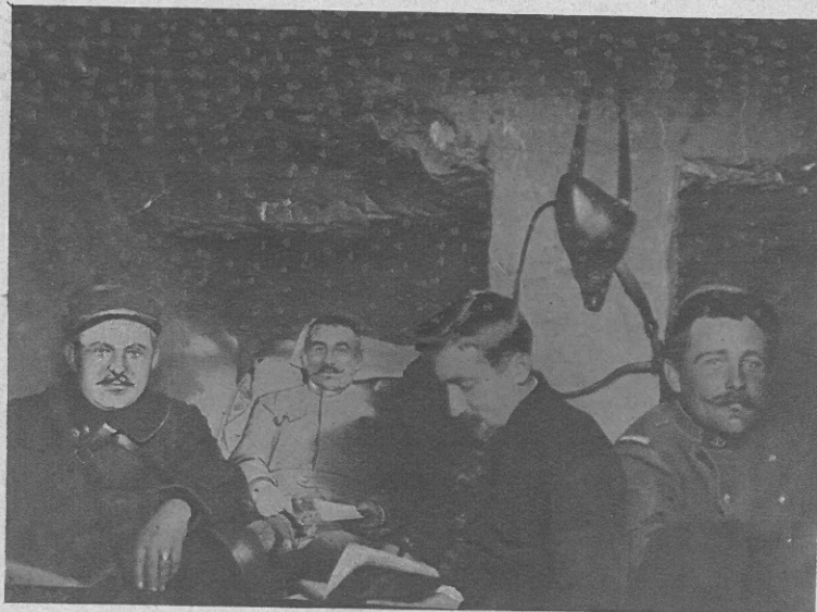
UNE CHAMBRE DE REPOS EN SECONDE LIGNE
