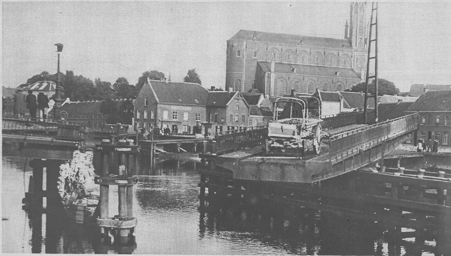
UN CAMION EST DEMEURÉ SUSPENDU SUR LE PONT DÉTRUIT DE NIEUPOORT
