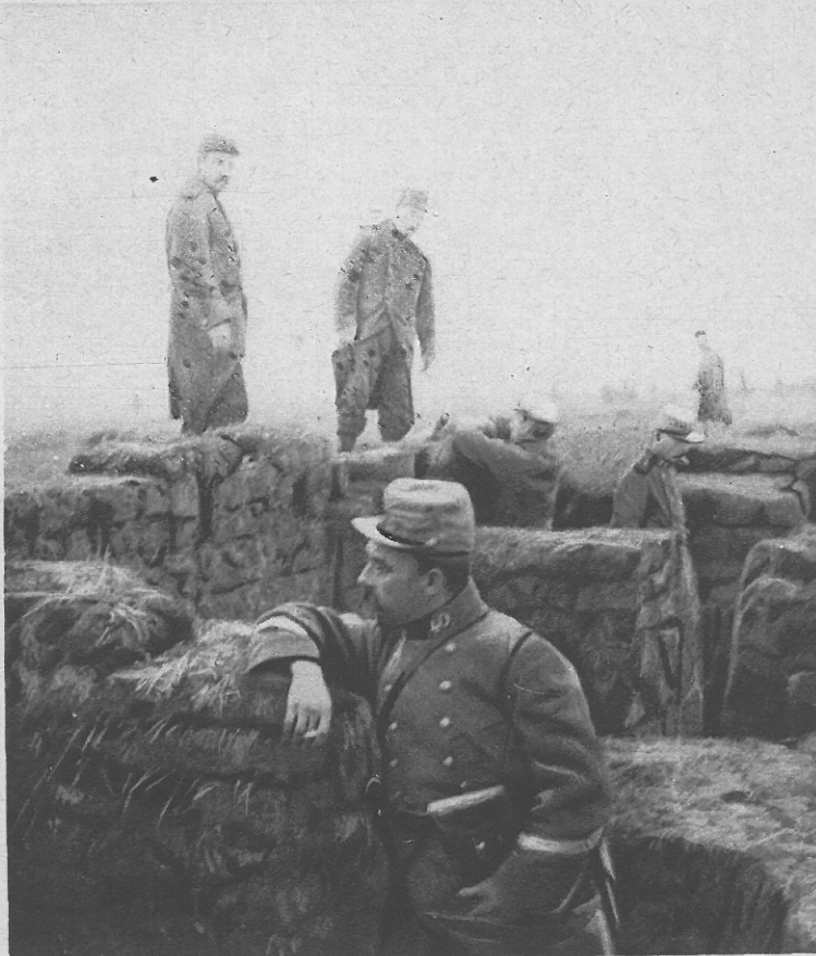
TRANCHÉE EN VOIE D'ACHÈVEMENT DANS L' AISNE
