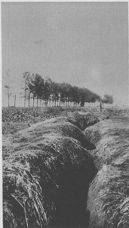
UNE TRANCHÉE PRÈS DE REIMS
