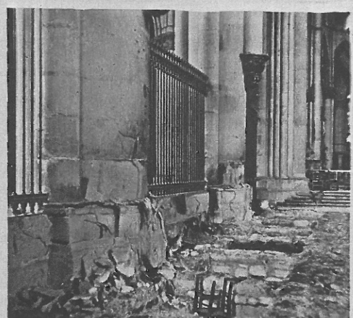
Un bas-côté derrière les stalles.
