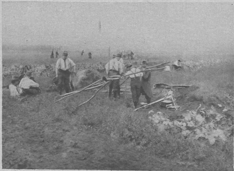
ÉDIFICATION D'UN ABRI POUR MITRAILLEUSE
