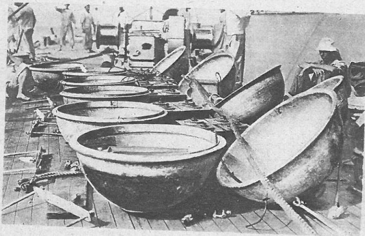
Les mines, ouvertes sur le pont, sont prêtes à recevoir les charges explosives et le mécanisme de conflagration.
